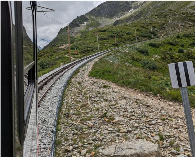
*Même avec ce tracé présentant une pente moyenne de 150mm/m pouvant aller jusqu'à 240mm/m, le système RUGLEI est parfaitement adapté.*
