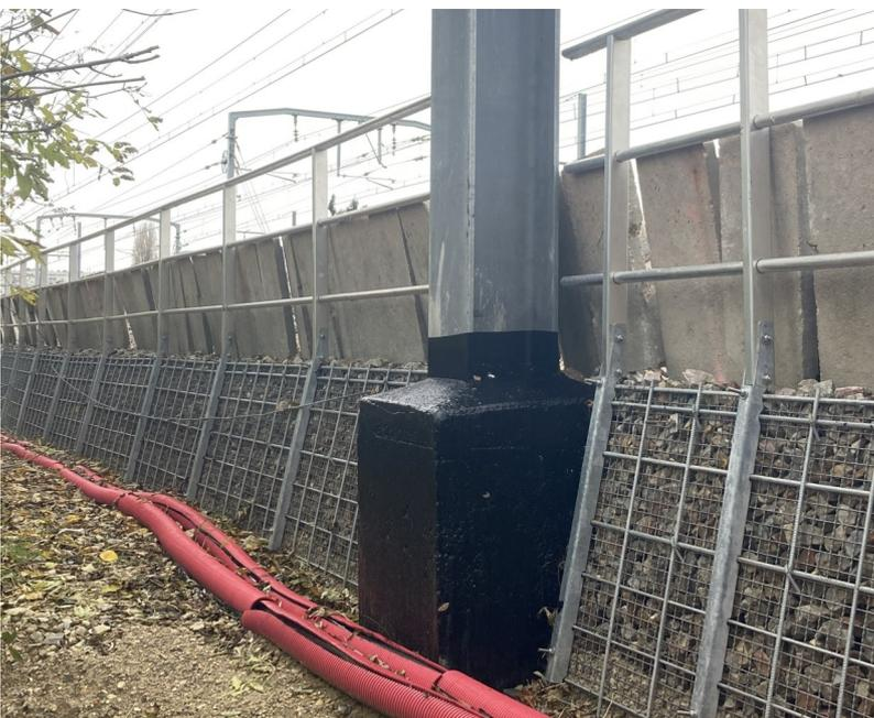
*Franchissement de massifs béton avec interruption du garde-corps*
