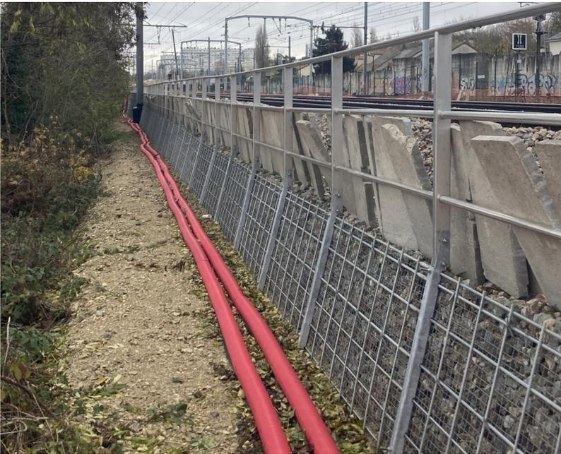
*Garde corps type VM7 avec embase de fixation sur système RUGLEI*
